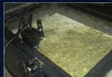
ファインバブル浄化装置によって浮上した汚れ
