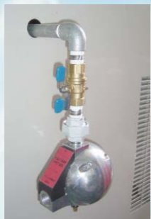
冷凍式ドライヤーの ドレン排出に!
